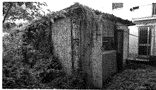
Vista esterna ripostigli oggetto di stima
