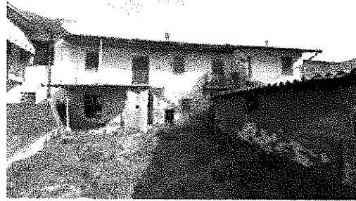
Vista posteriore della porzione abitativa con in primo piano sulla destra il fabbricato ad uso ripostiglio privo di titolo abilitativo edilizio
