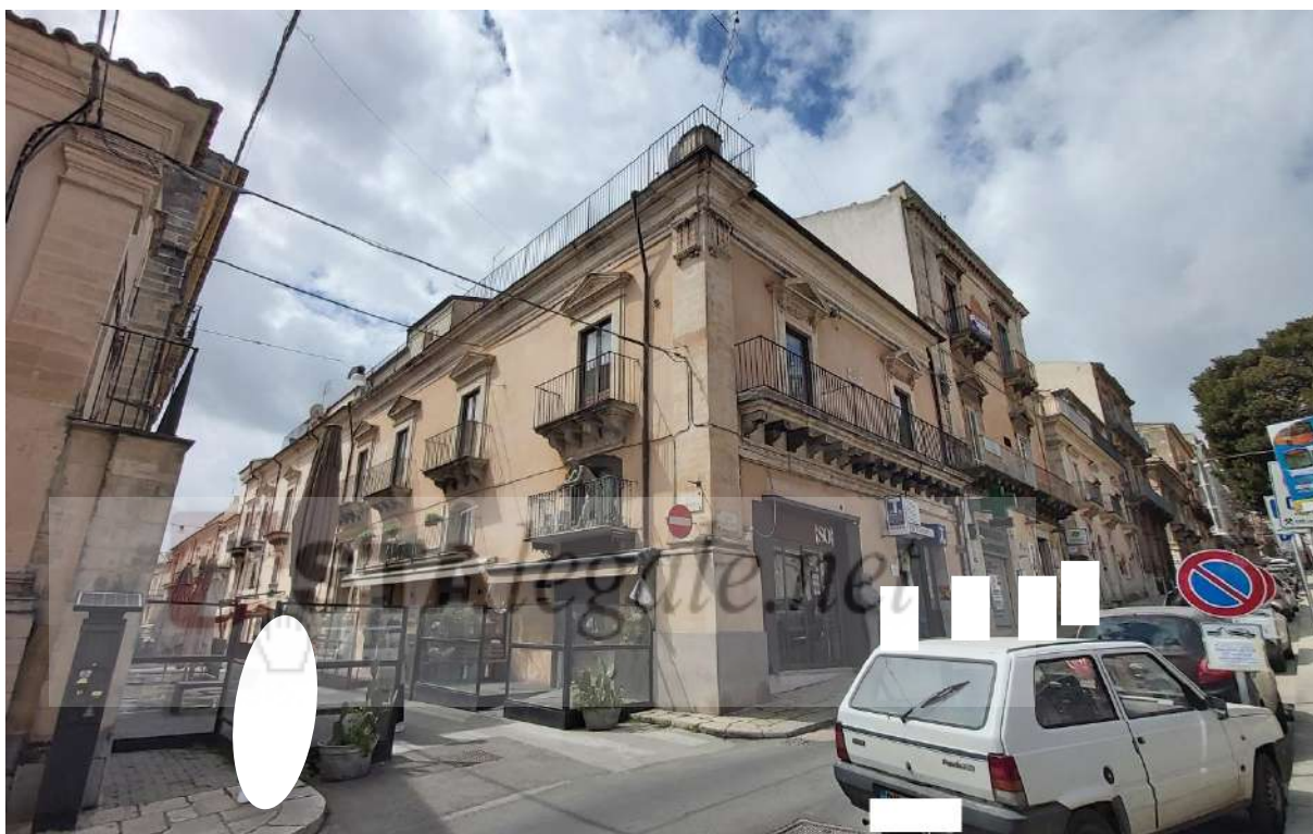
Foto n. 01 – Prospetto Via Mariannina Coffa angolo Corso Vittorio Veneto (Foglio n°280 Particella n°2303).
