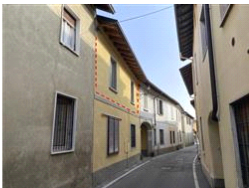
Fabbricato in via Don Sebastiano Colleoni con ingresso dal num. civico 32 Prospetto sud - Appartamento al piano primo Fig. 5 (ex 9) Part. 515 Sub. 23
