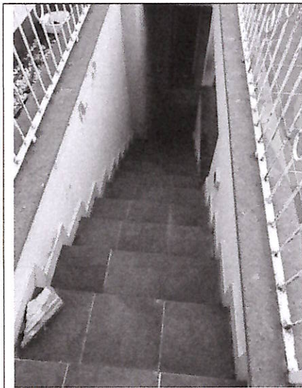
Accesso locale interrato
