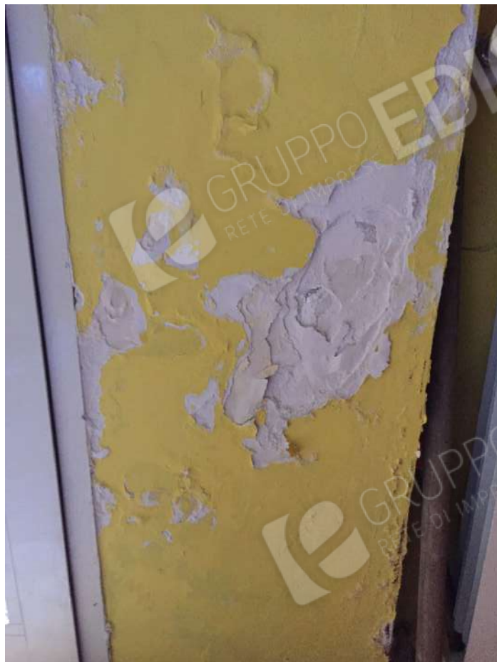
Dettaglio infiltrazioni
