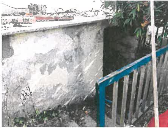
ACCESSO AL PIANO INTERRATO
