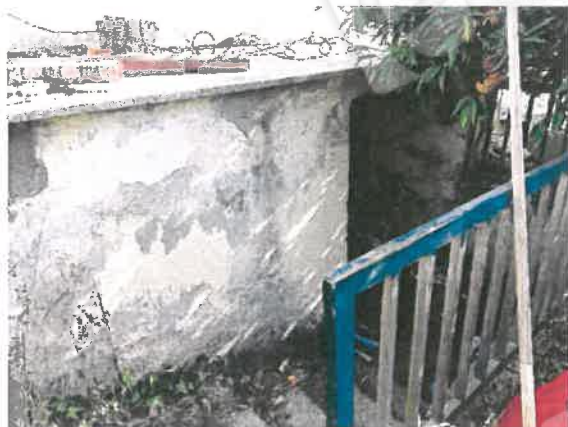
ACCESSO AL PIANO INTERRATO
