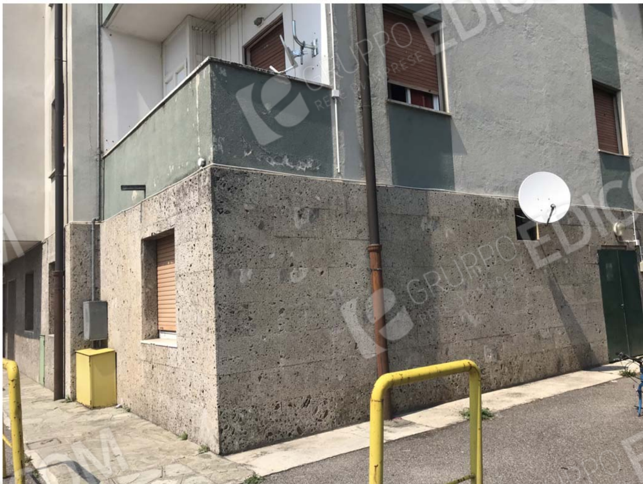
Foto 5 – Dettaglio del rivestimento esterno piano terra
