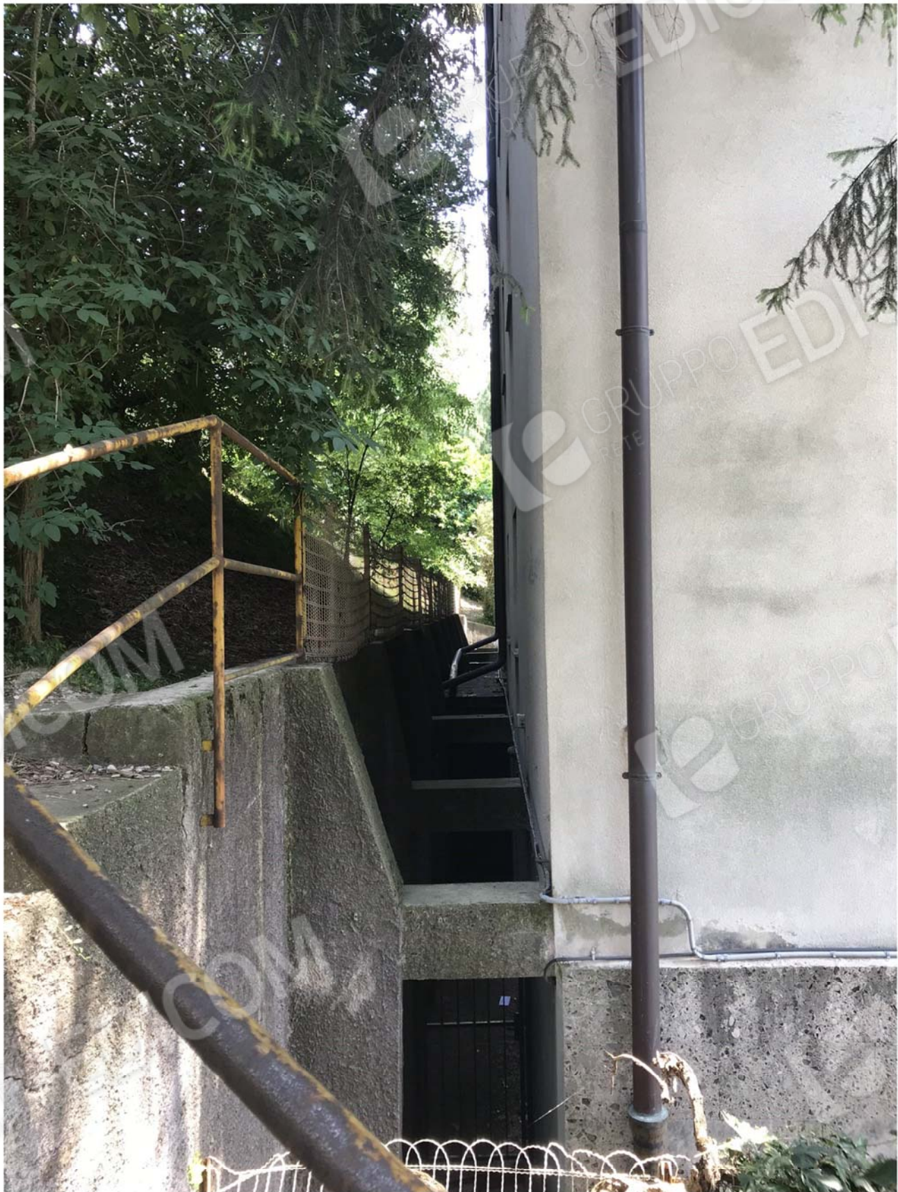
Foto 8 – L'area circostante il fabbricato
