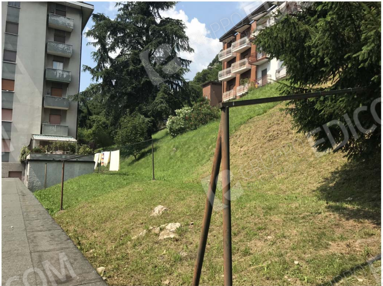
Foto 7 – L'area circostante il fabbricato
