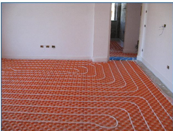
Posa pannelli radianti
