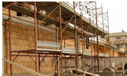
Le strutture portanti sono costituite da telai con **pilastri e travi in cemento armato** e da solai realizzati con travetti precompressi e/o laterizi. L'inserimento delle pignatte e dell'armatura del ferro sovrastante/rete elettrosaldata creerà un corpo unico per dare il massimo della consistenza alla struttura.
