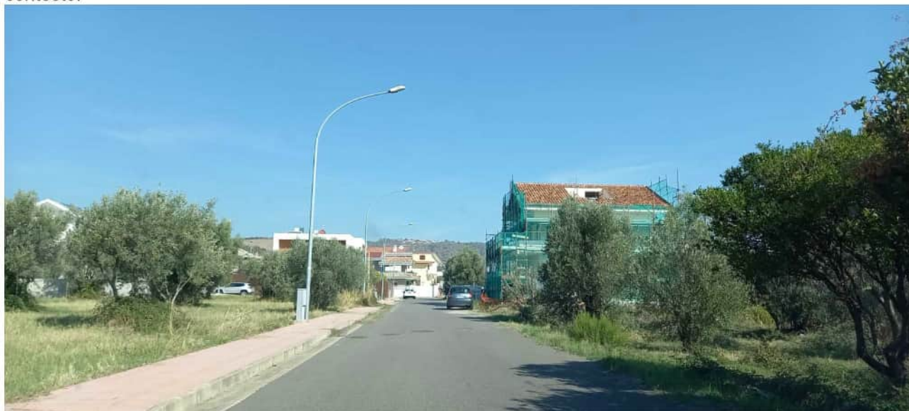
Strada di accesso al lotto
