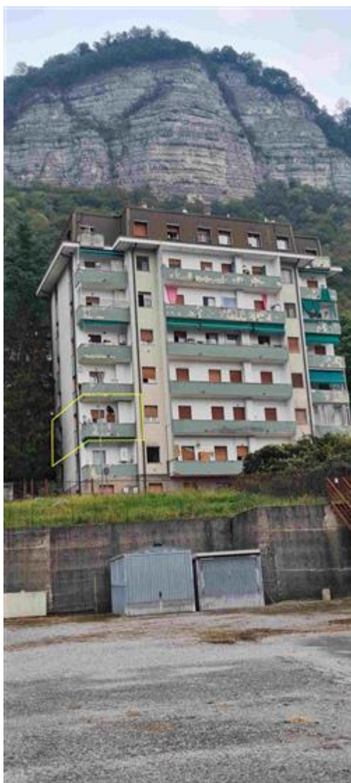
Vista fronte sud-ovest.
