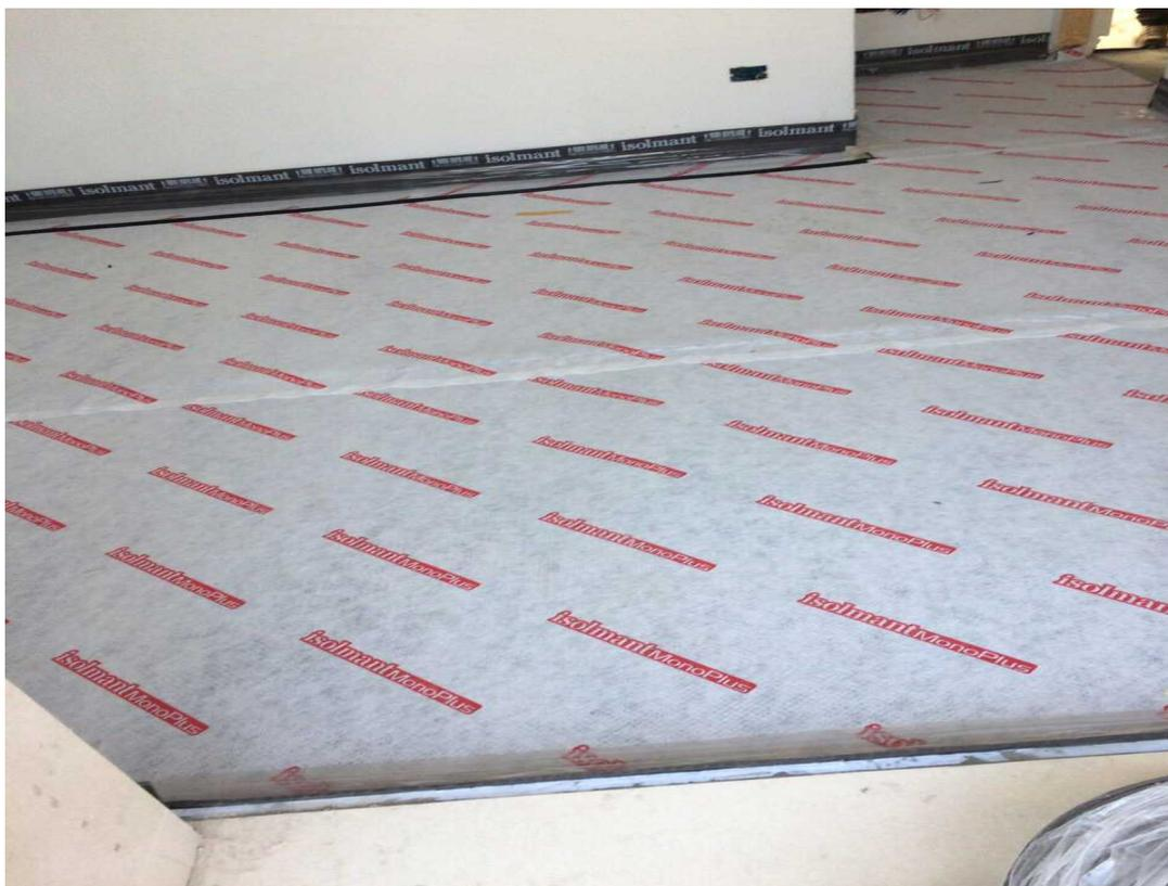
*Tappeto acustico e fascia perimetrale prima della posa del riscaldamento a pavimento*
