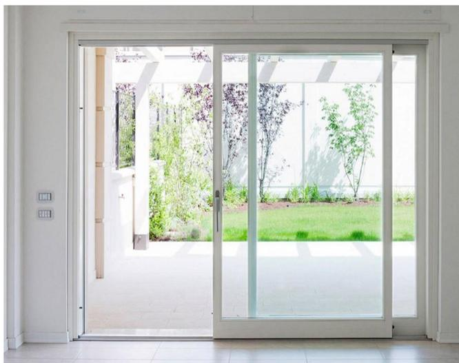
I serramenti saranno del tipo ad ante a battente o del tipo alzante scorrevole su binari di scorrimento inserite in soglie di alluminio di appoggio completi di maniglioni per l'apertura e chiusura in acciaio cromo satinato di qualità.
