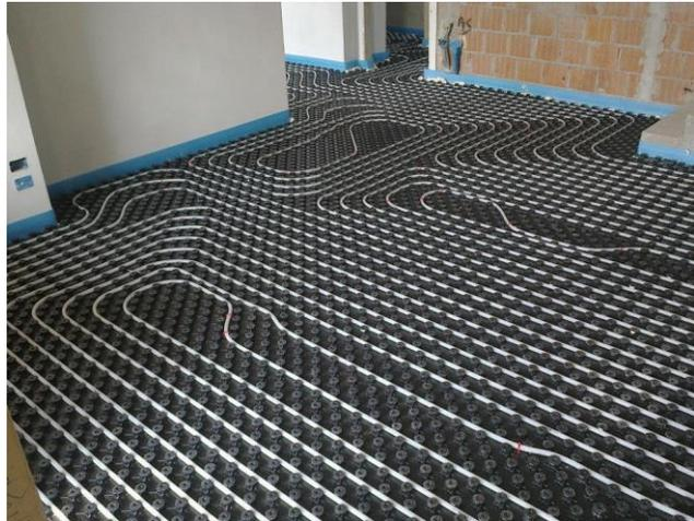
Tale condizione risulta quindi ottimale per lo sfruttamento di sistemi di generazione dell'energia termica a bassa temperatura quale appunto la pompa di calore.
