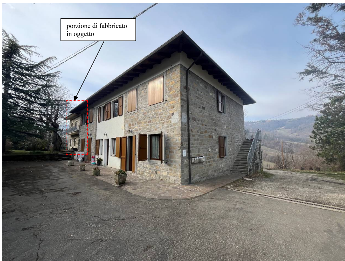
1. Vista del fabbricato dalla strada
