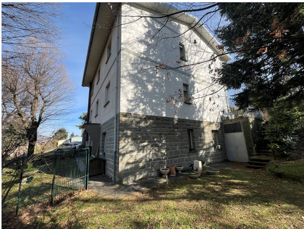
2. Vista del fabbricato dal cortile comune
