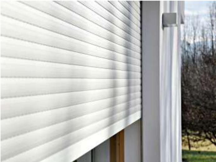
Le finestre sono dotate di tapparelle avvolgibili in alluminio inserite in cassonetti (incassati a filo muro) con isolamento termoacustico. gli avvolgibili che verranno installati saranno di prima qualità. per rendere ancora più elevato il comfort e la qualità della casa in cui andrete a vivere, le tapparelle saranno completamente motorizzate si singolarmente che centralmente tramite un unico tasto di apertura e chiusura, per tutti gli avvolgibili della vostra unità abitativa, così da rendere
