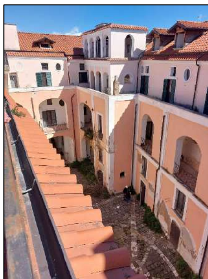
Figura 7 - Vista su cortile interno
