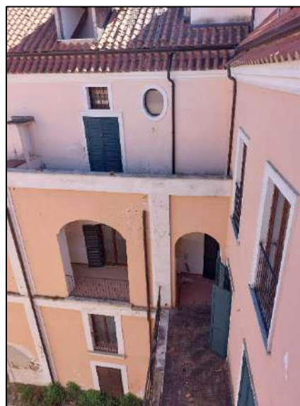
Figura 9 - Vista su cortile interno
