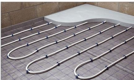
La distribuzione del fluido termovettore è del tipo a pavimento, mentre il collettore sarà installato in apposita cassetta di contenimento, dal quale saranno derivati i circuiti indipendenti di ogni locale.
