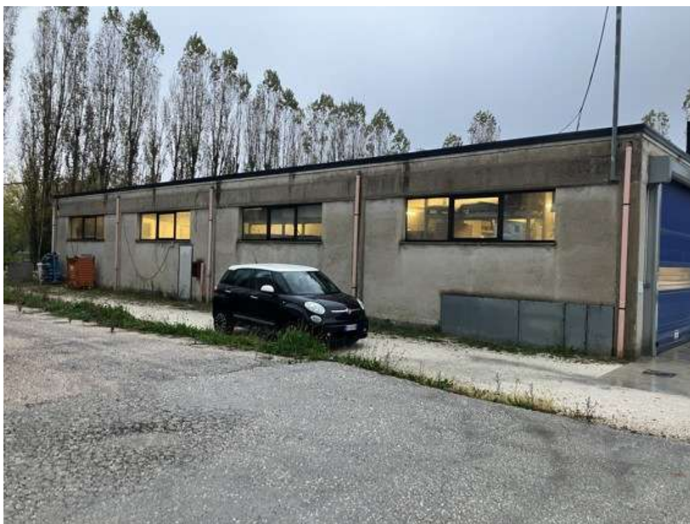
Fotografia E.3 - Prospetto Ovest
