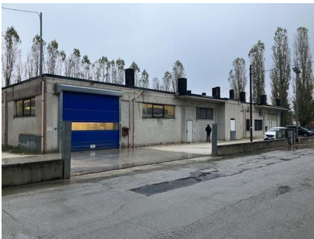
Fotografia E.2 - Prospetto Sud
