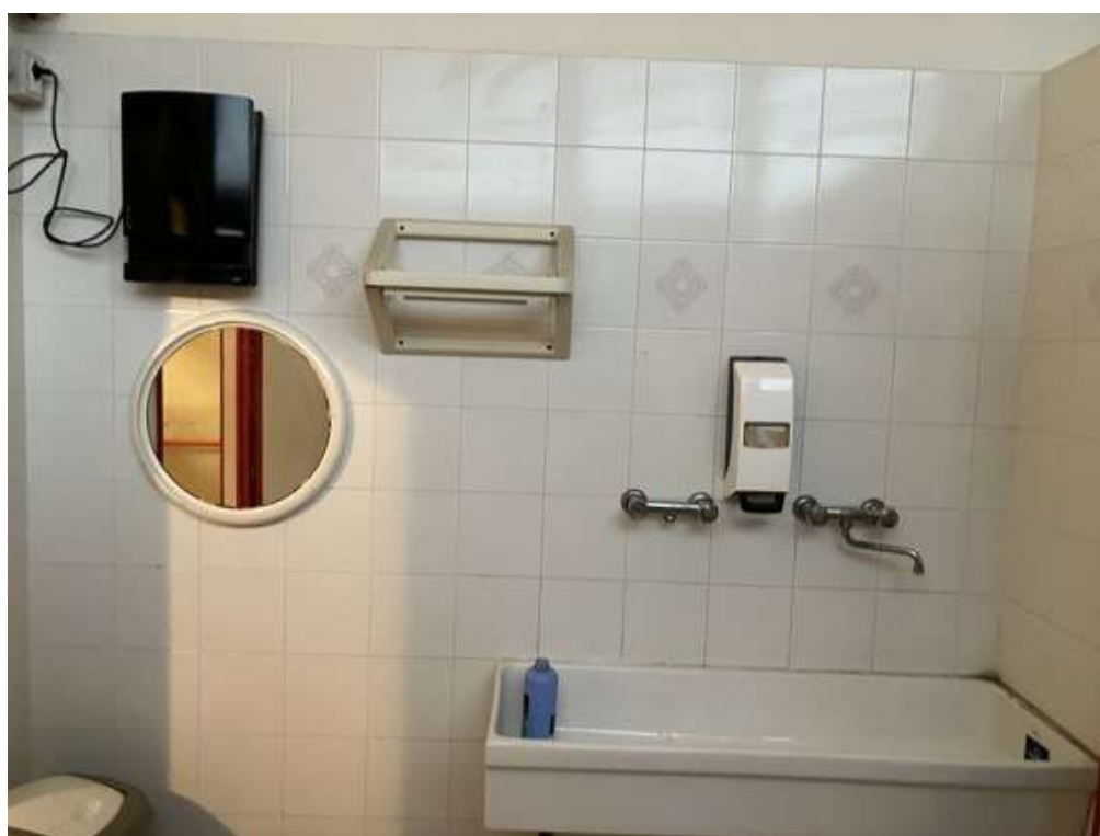
Fotografia E.10 - Spogliatoio
