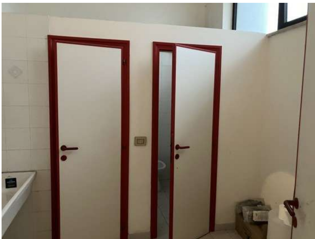
Fotografia E.9 - Spogliatoio
