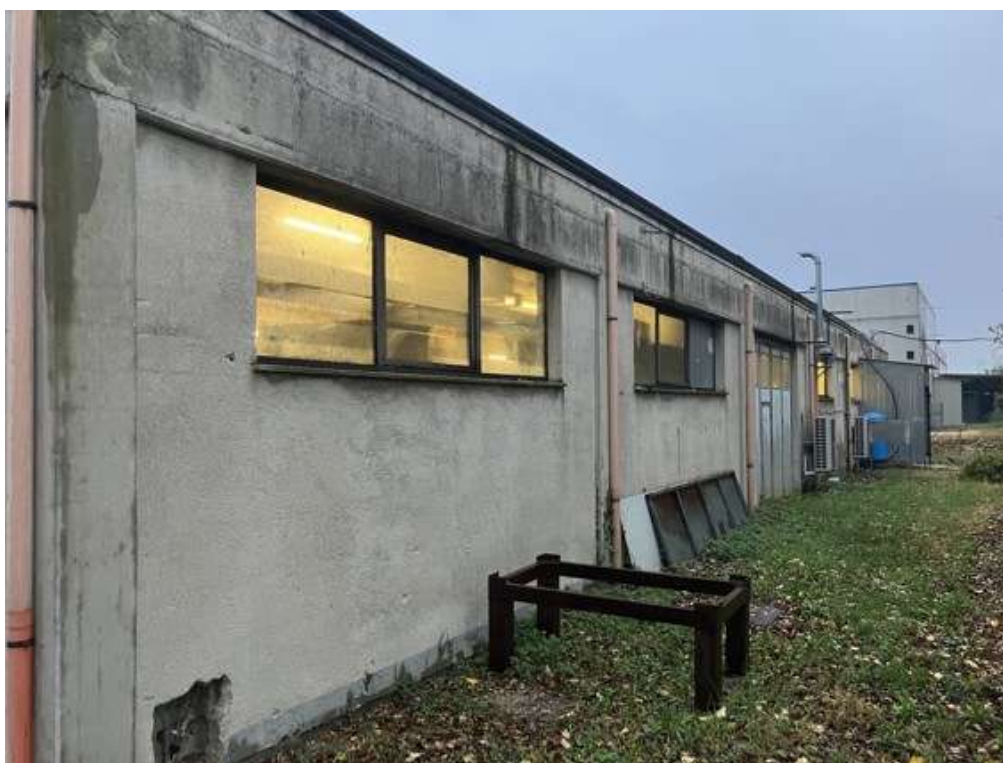
Fotografia E.4 - Prospetto Nord
