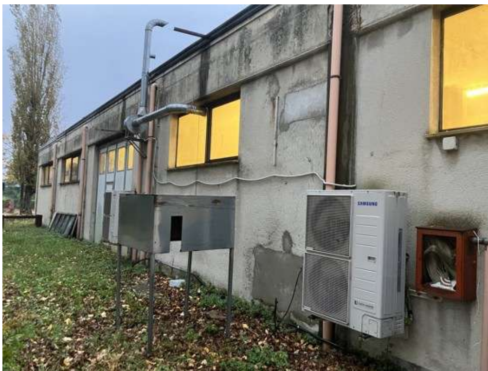
Fotografia E.5 - Prospetto Nord
