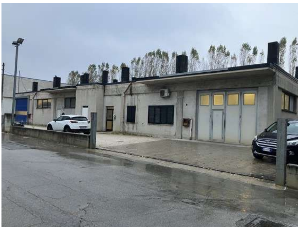
Fotografia E.1 - Prospetto Sud
