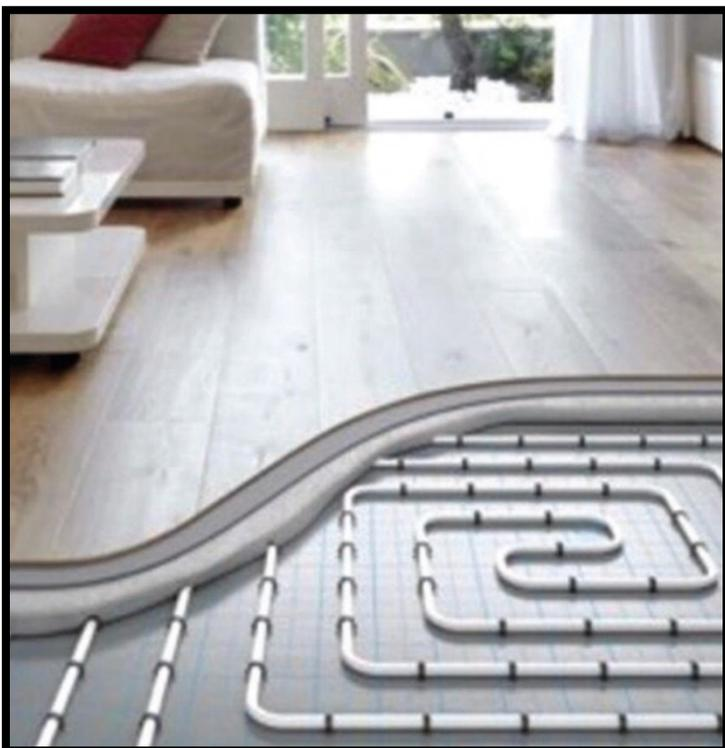
L'impianto di riscaldamento sarà del tipo "a pavimento", dove circola acqua calda a "bassa temperatura",
