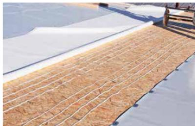
La membrana **EVALON® V** è accoppiata sul lato inferiore con un feltro di tessuto in poliestere che la protegge dalle imperfezioni sulla struttura di posa. Il tessuto non tessuto (TNT) non protegge solo la membrana, ma offre anche il vantaggio di poter impermeabilizzare la copertura in un unico passaggio di posa, senza dover stendere un ulteriore strato protettivo.
