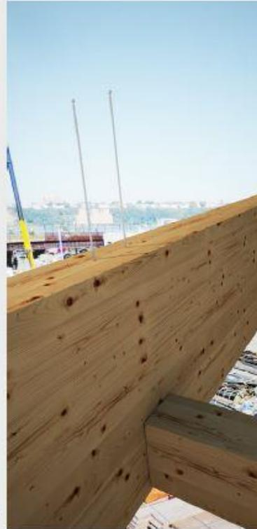
Rinforzo ortogonale alla fibra per carico appeso > dovuto a giunzione trave principale-secondaria.
