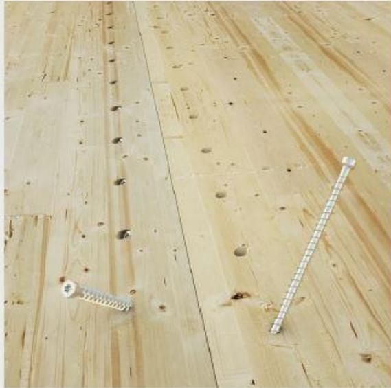
Giunzione ad elevatissima rigidezza di solai in X-LAM affiancati. Applicazione con doppia inclinazione a 45° ideale da realizzare con dima JIG VGZ.
