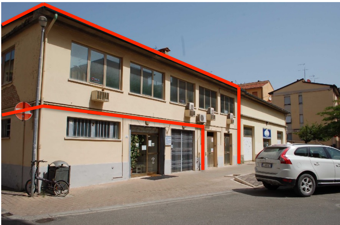
ingresso da Piazza Palermo civ. 18 (ufficio) e 20 (magazzino)
