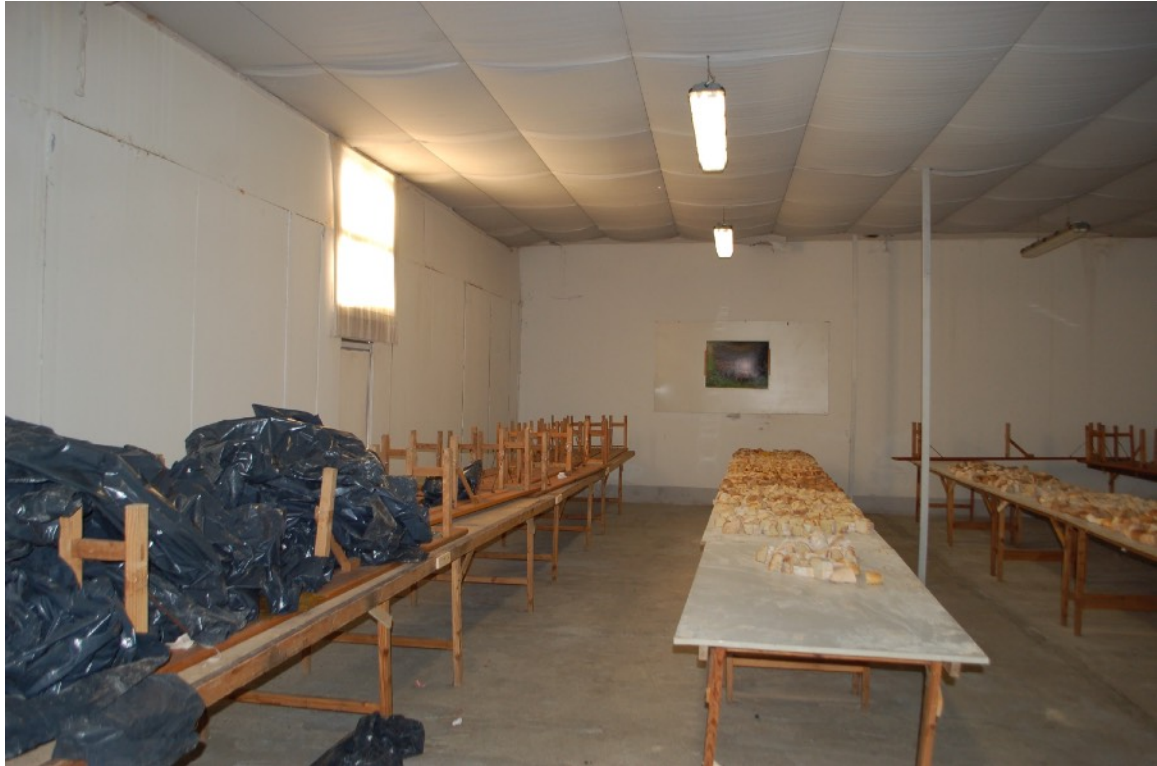
9) interni tettoia tamponata
