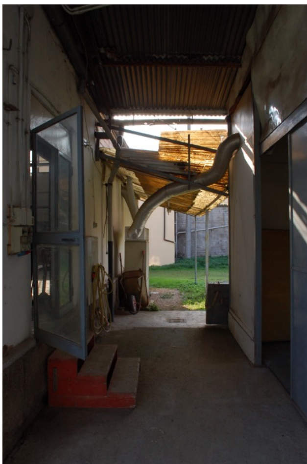
7) passaggio tra fabbricato principale e tettoia tamponata
