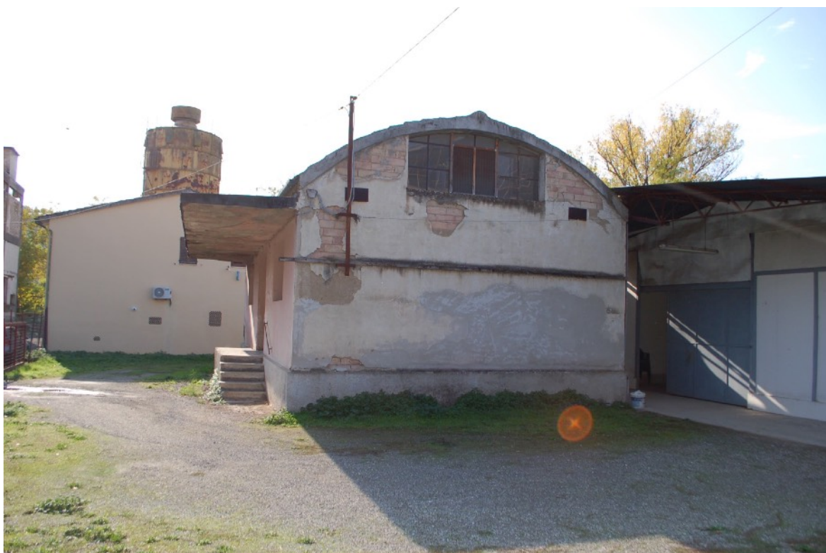
6) ripostiglio condonato non più presente
