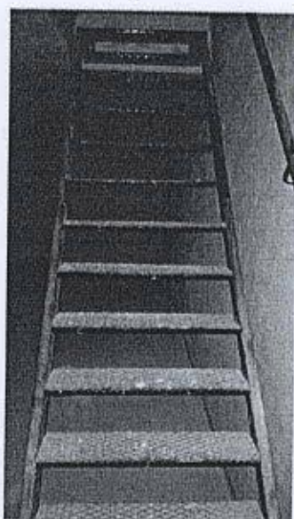
Scala di accesso dal garage alla cantina
