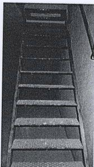
Scala di accesso dal garage alla cantina
