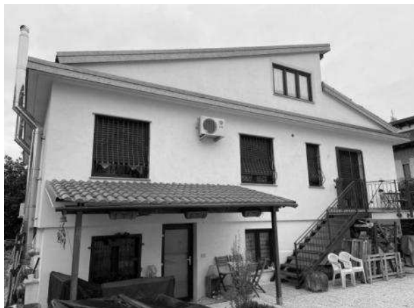
Vista interna lato cortile
