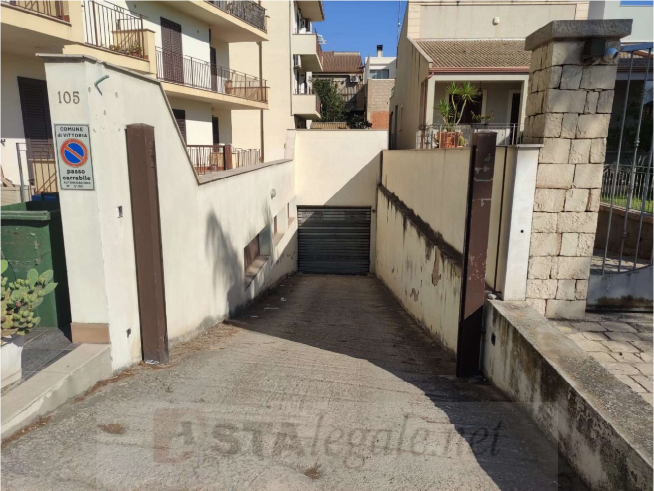
Accesso al box auto da Via Strada per Scoglitti
