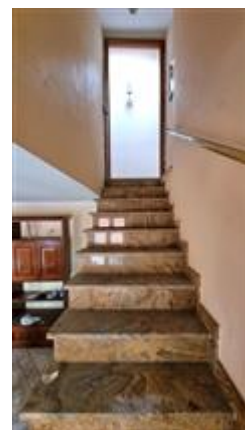
scala da demolire
