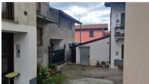
ingresso da strada
