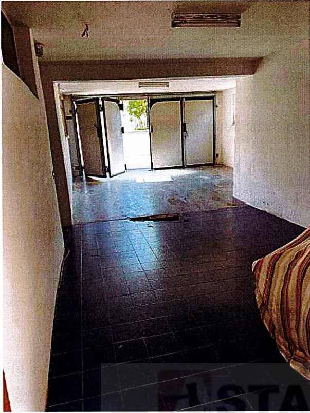
Foto 05: Autorimessa, vista interna
