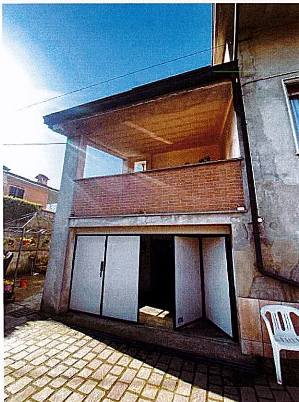
Foto 04: Ingresso esterno autorimessa – vista della terrazza dell'appartamento Corpo A
