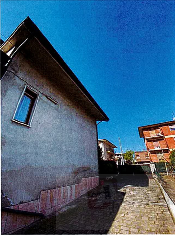
Foto 03: ingresso carraio da via Giotto
