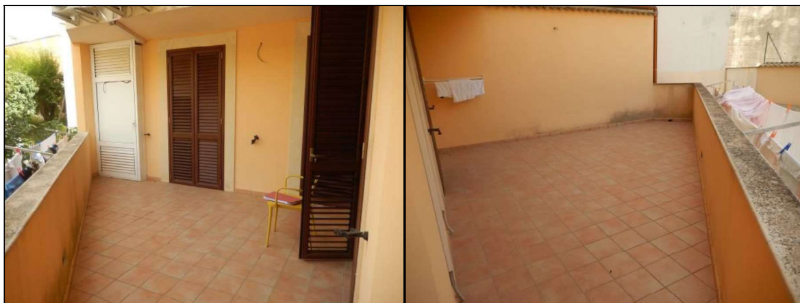
Foto 25: Balconi n. 2 al Piano Primo
