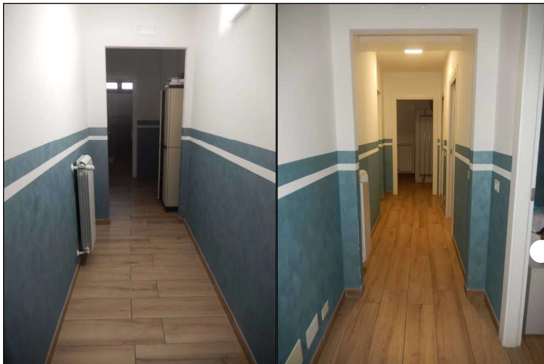
Foto 16: Corridoio d'ingresso al Piano Primo
