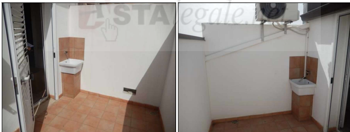
Foto 46: Terrazzini n. 2 e 3 al Piano Terzo
