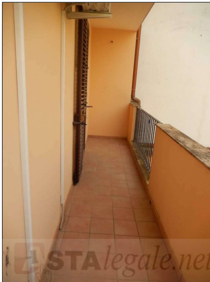
Foto 38: Balcone n. 2 al Piano Secondo
