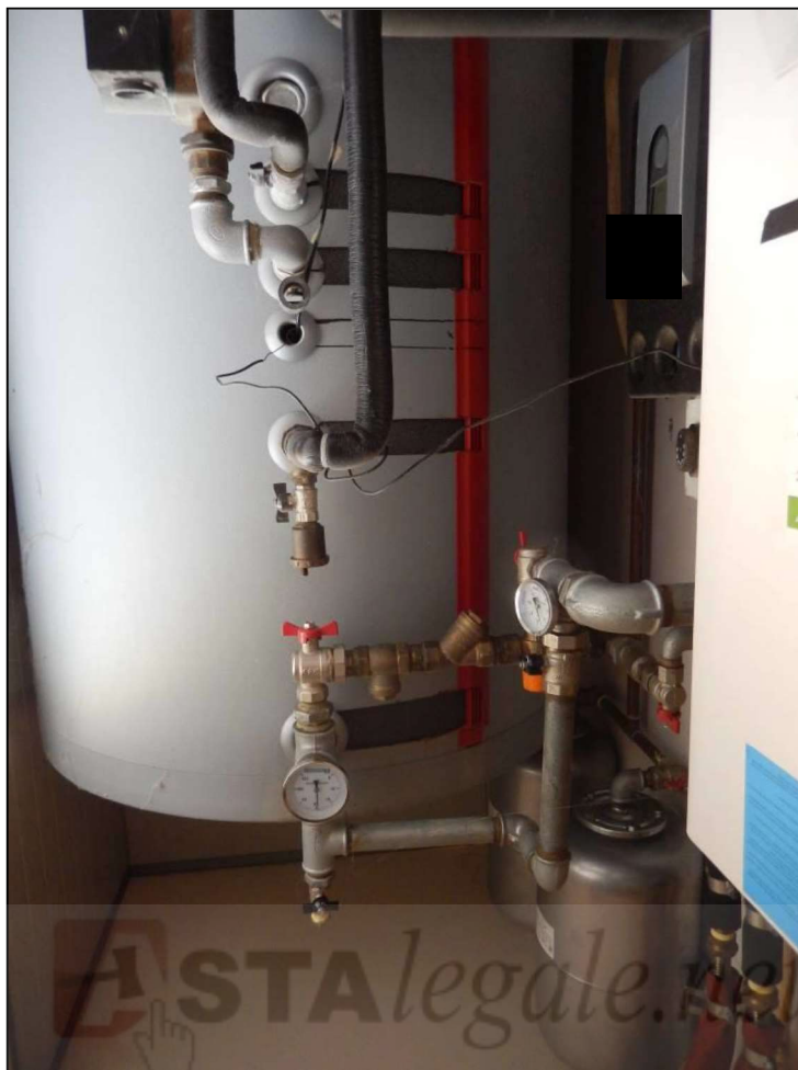
Foto 13: Vano Caldaia al Piano Terra
