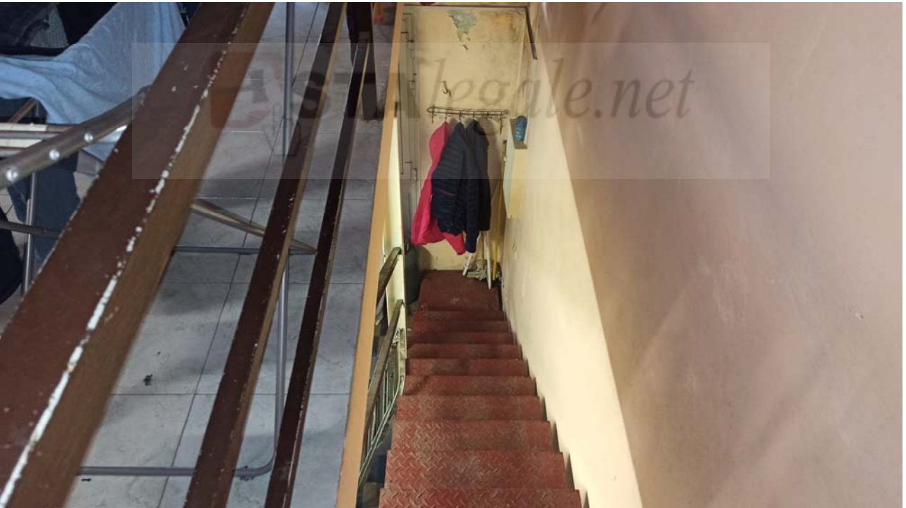
Scala di accesso sottotetto (civico 362)
