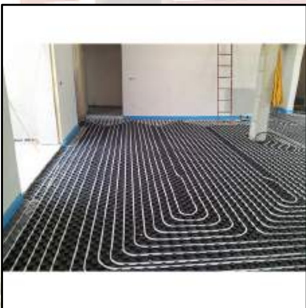
Figura 10: Esempio di impianto di riscaldamento a pavimento
