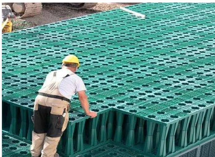
del tipo "Rigofill" attraverso il quale le acque meteoriche vengono in parte trattenute (fase di laminazione) e poi gradatamente drenate nel sottosuolo (fase di recapitazione). Il suddetto sistema, costituito da elementi parallelepipedici modulari realizzati in materiali plastici meccanicamente resistenti
