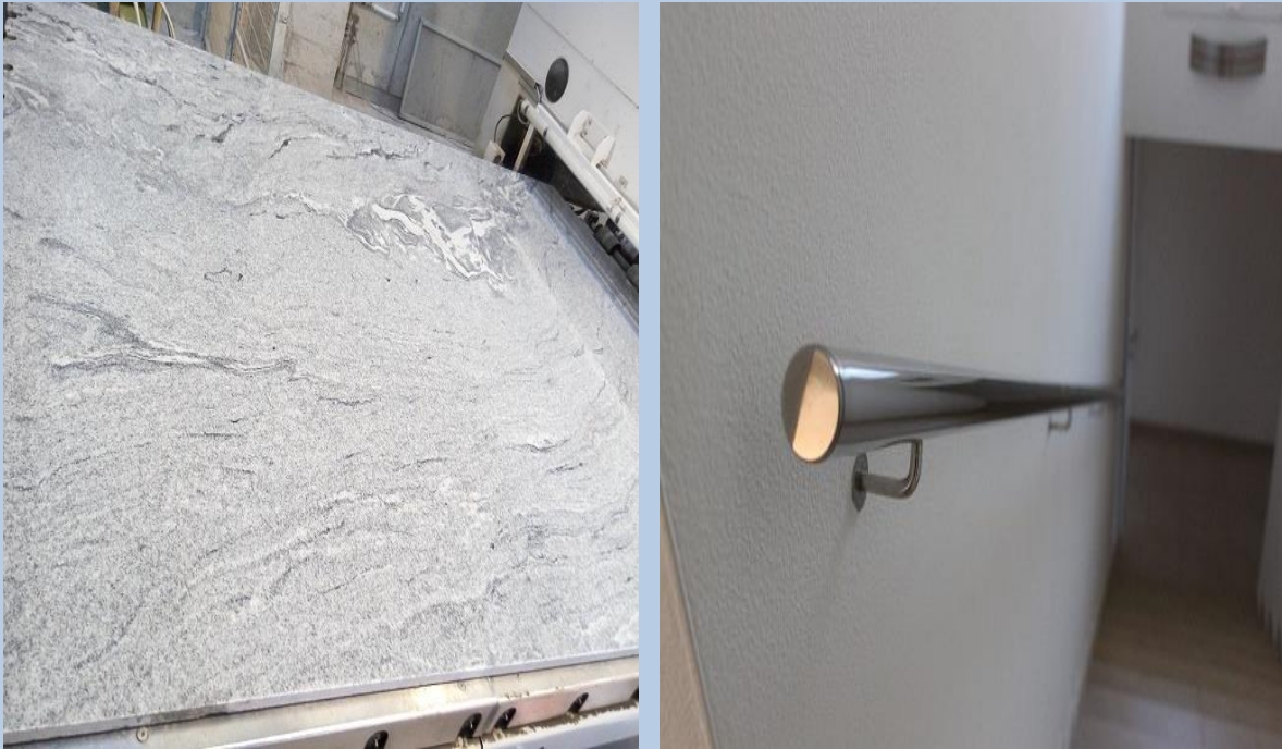
Esempio: Rivestimento scala in pietra naturale e corrimano in alluminio cromato.
