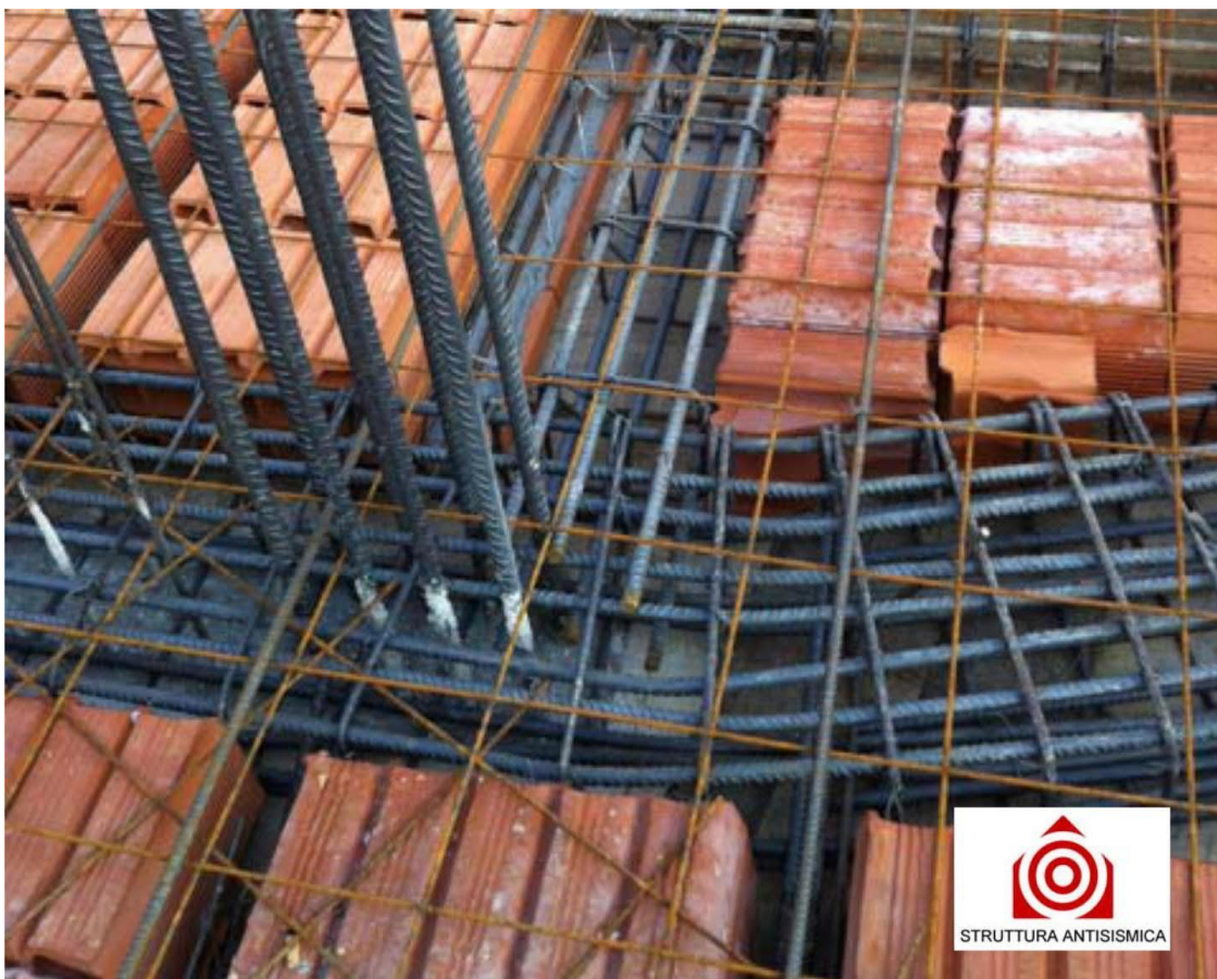
Particolare nodo strutturale antisismico
