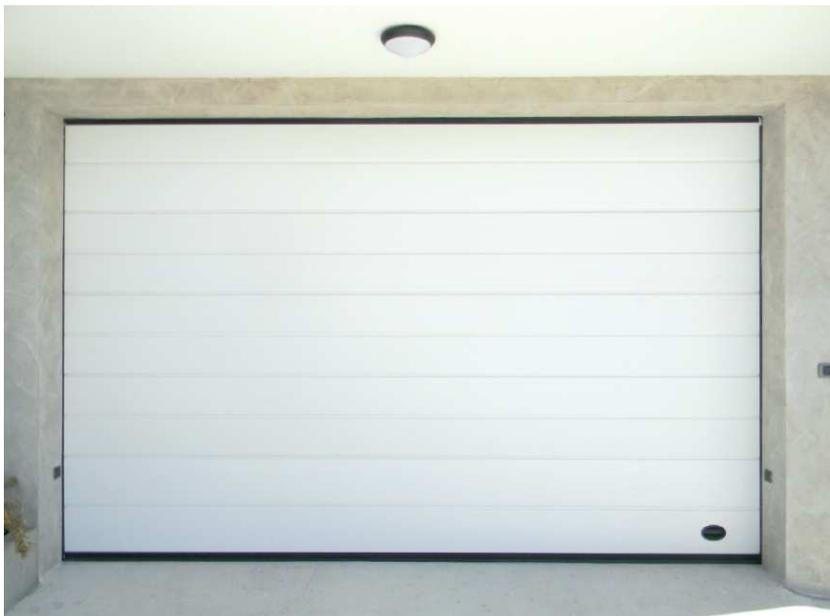
**Portone sezionale** per box con apertura elettrica costituita da una doppia parete in alluminio isolato con successivo trattamento primer e verniciatura con resine poliesteri con procedimento specifico di colore a scelta della DL, dotata di telecomando.
