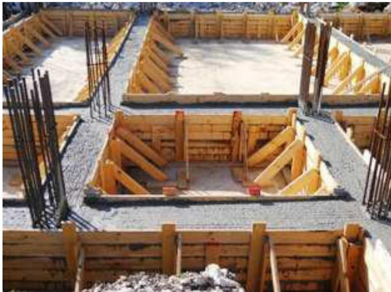
Magrone per le sottofondazioni eseguiti in getto di calcestruzzo dosato a q.li 1,5/mc di cemento R 325/mc, gettato senza l'ausilio di casseri e senza ferro di armatura sotto tutte le fondazioni. Fondazioni continue o plinti in getto di calcestruzzo, gettati con l'ausilio dei casseri, secondo le dimensioni di calcolo, compresa armatura in ferro in ragione del calcolo e con caratteristiche di dosatura precisate nei calcoli dei cementi armati, calcoli eseguiti da tecnico abilitato.
