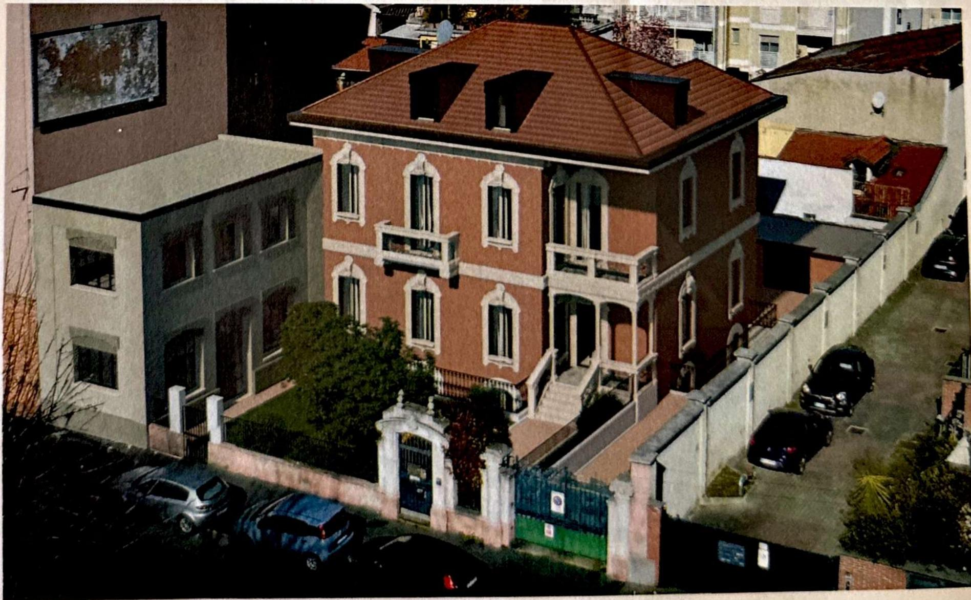
Per garantire le migliori caratteristiche prestazionali dell'involucro mantenendo le cornici ed i fregi originali esistenti, l'involucro edilizio è stato coibentato sia internamente con materassini di isolante ed esternamente con l'applicazione di intonaco biologico speciale ad alta traspirabilità con impasto di sughero.
