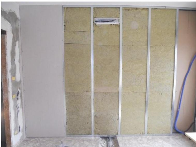
**Tavolato interno realizzato con struttura a secco in cartongesso**
