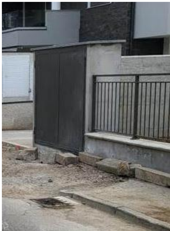
Figura 16 - Foto rappresentativa (non esaustiva) della recinzione esterna
