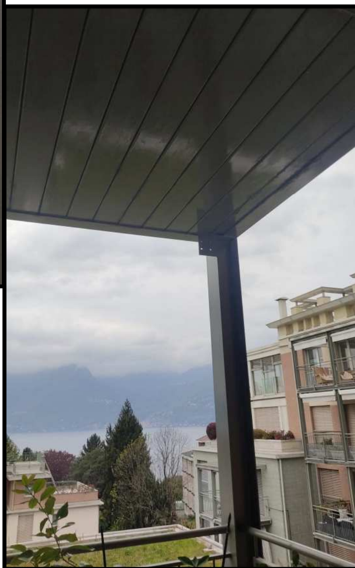
Vista da portico
