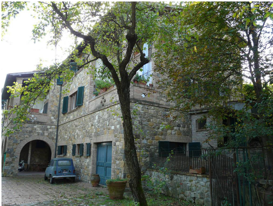
27-prospetto tergale del fabbricato
