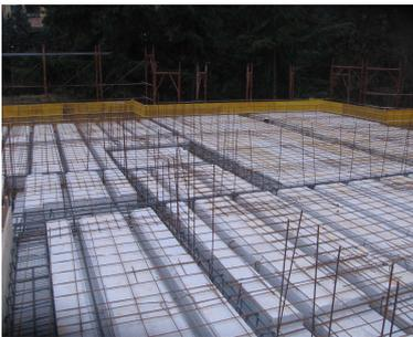
Il solaio interpiano verrà realizzato in **TERMOSOLAIO**. Il polistirene espanso impiegato garantirà un **elevato isolamento termico costante nel tempo.**
