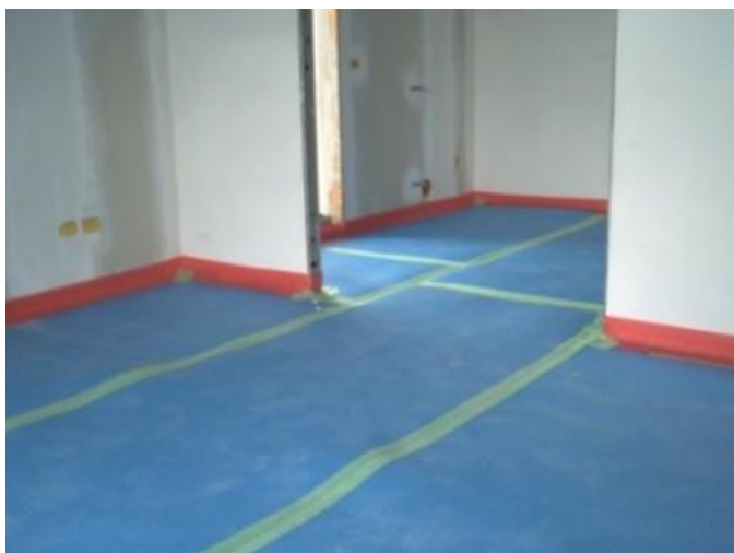
posa di tappetino fonoisolante applicato sotto il massetto di sottofondo
