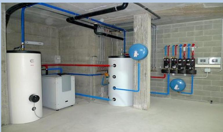
Esempio: Pompa di calore    Esempio: Addolcitore Acqua sanitaria
