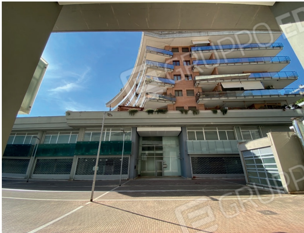
Foto n.1 Veduta esterna edificio
