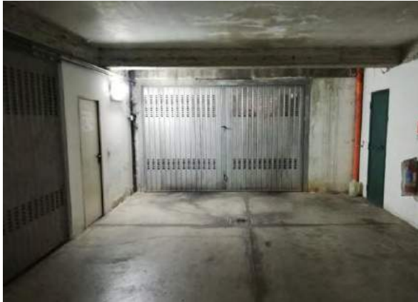
Esterno locale di deposito
