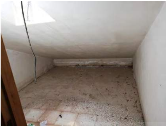
Interno locale di sgombero (sub. 14)
