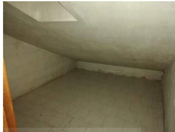
Interno locale di sgombero (sub. 13)
