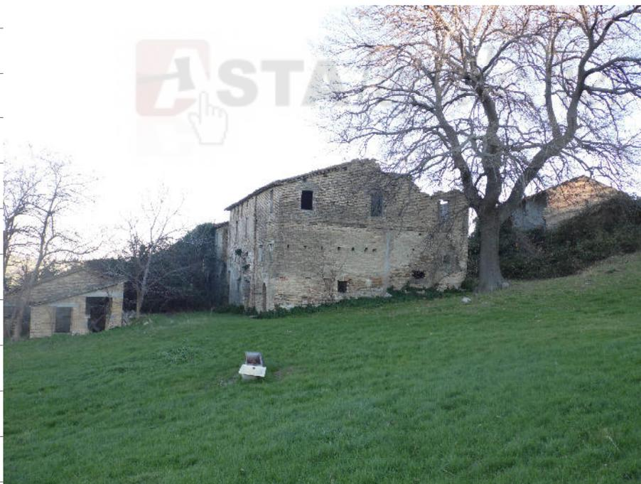
L'intero complesso è in stato di abbandono con folta presenza di rovi e vegetazione spontanea che impedisce anche l'accesso a parte della proprietà. Tutti i corpi sono in muratura portante di mattoni pieni e solai in legno con presenza di porzioni di struttura crollate ed altre gravemente lesionate ben visibili anche dalla documentazione fotografica **(Allegato 17).**
