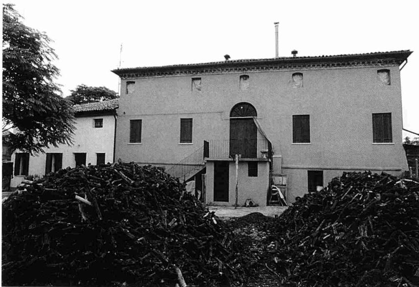
posizione di quasi tutti i setti. L'edificio risulta composto da due corpi. Il principale di essi, in parte in mattoni, ha pianta tripartita, disposto su due piani più un sottotetto. La scala, non visibile nella mappa del 1775 e probabilmente ricostruita di recente al centro della facciata, conduce all'accesso situato al primo piano del lato ovest. Individuato da un portale ad arco a tutto sesto, è tuttavia privato dell'originale cornice in pietra.
