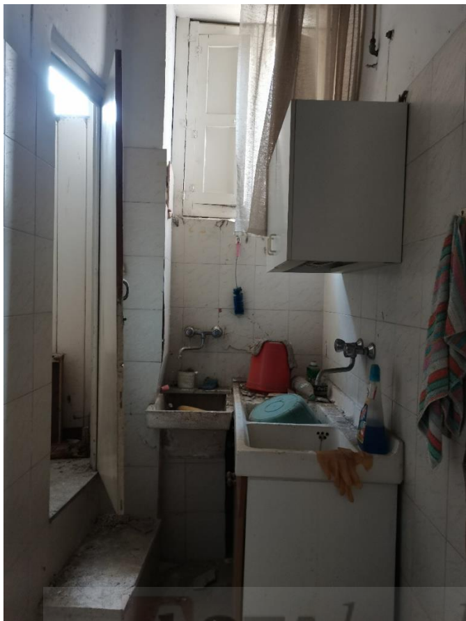
FOTO 5 – disimpegno-cucina (piano terra)
