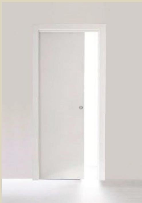
Le porte interne agli alloggi saranno a battente o scorrevoli tipo Scigno (come da progetto), con ante tipo tamburato pieno e ossatura perimetrale con essenza in legno. Il riempimento della struttura è in alveolare semiresinato.
